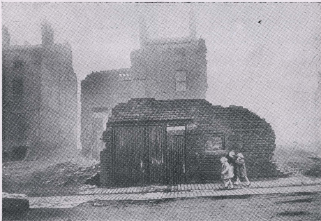
"Area sendo demolida em Liverpool" — 1963
